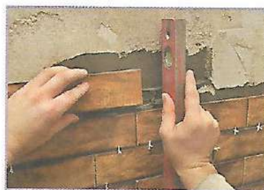
Рис. 6.9. Кладка кирпича (а) и монтаж плитки (б) на цементных растворах
