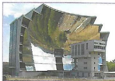
Рис. 9.6. Солнечная печь во Франции, работающая на сфокусированных солнечных лучах
