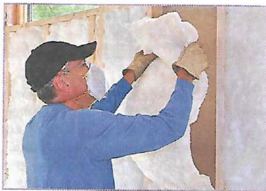
Рис. 9.13. Уменьшение потерь тепловой энергии — утепление стен домов
