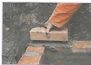
Рис. 6.9. Кладка кирпича (а) и монтаж плитки (б) на цементных растворах
