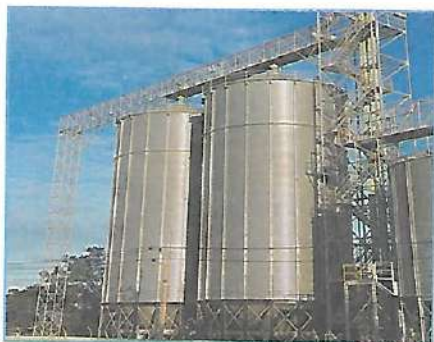
Рис. 11.4. Силосно-сенажные башни
